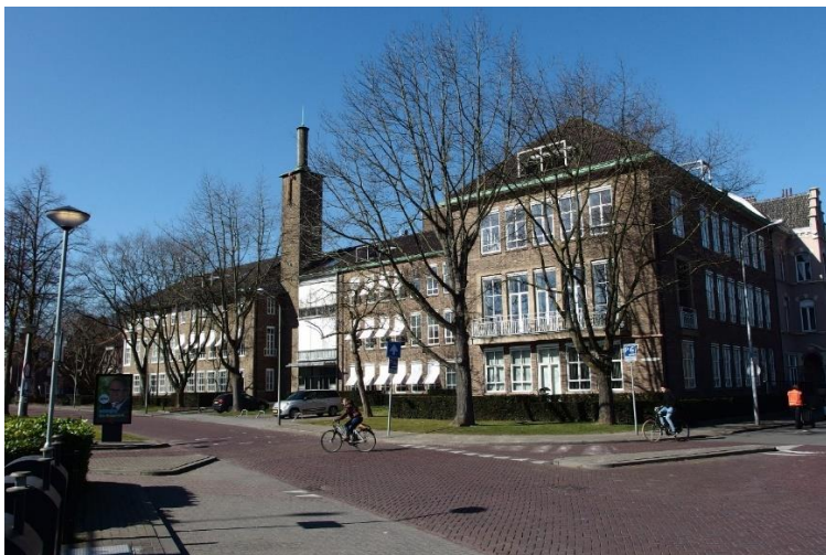
PLEM-gebouw aan de Prins Bisschopssingel 2-4 te Maastricht
