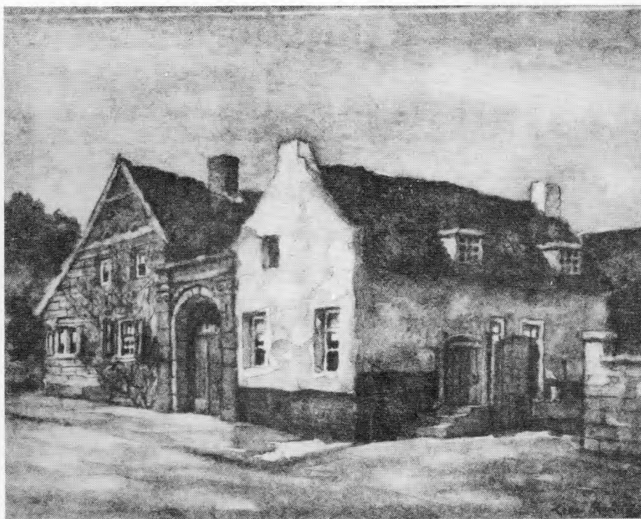
Maartens-hoeve met woning naast de poort. gebouwd door Mathias Curfs in 1835 en afgebroken in 1930.
