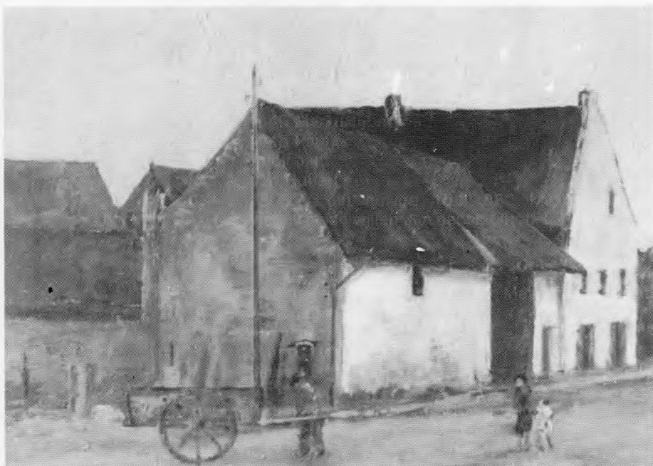
Woning Sleijpen-Roebroeck-Willems, afgebroken.
