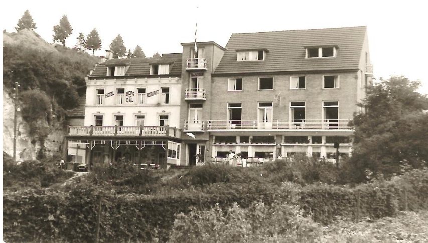
Hotel Berg en Dal, 1939 (aanbouw rechts dateert uit 1935)
