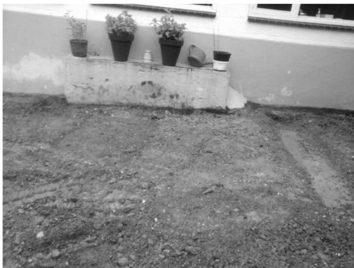
Profiel van de weg. Onderin lagen de Maaskeien
